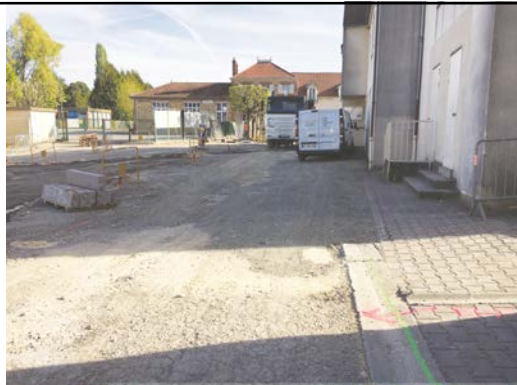
Préparation du fond de forme
