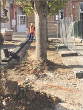
Pose des dispositifs d'évacuation des eaux de pluie
