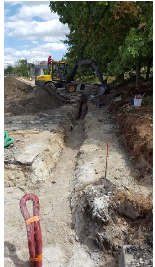
PS : travaux d'assainissement
